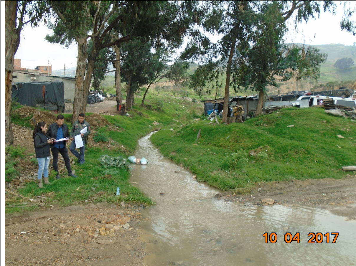
Figura 2. Punto de intervención del Box Coulvert desde otra vista coordenadas así: X=91731,32 y Y=95907,99
